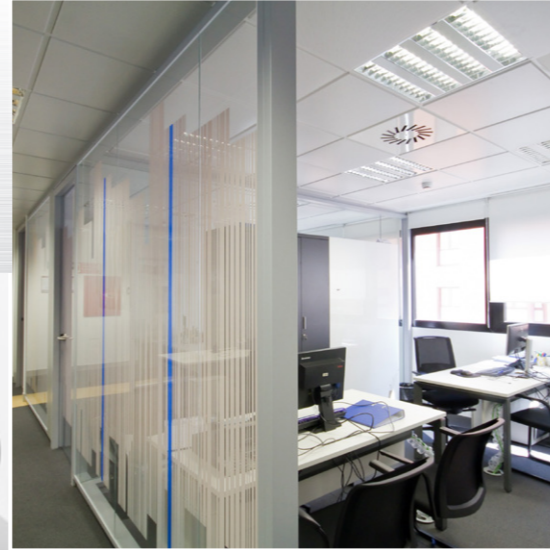
Sistemas de techo suspendido con bandejas metálicas de 600x600mm
