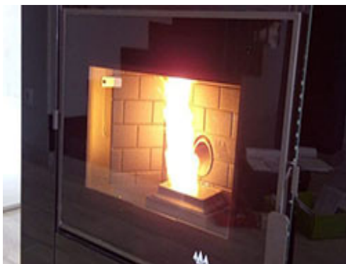
Termochimenea de pellets para calefactar vivienda con radiadores
