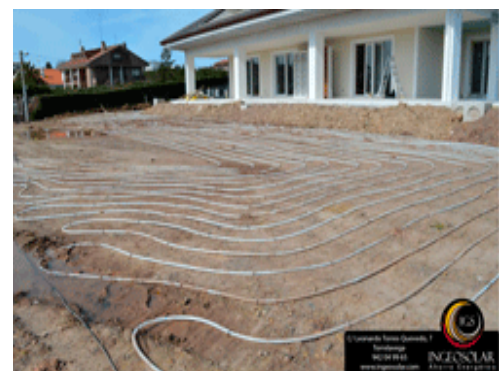
Instalación de geotermia en una vivienda unifamiliar en Cantabria
