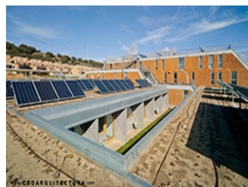
Instalación de ventilación mecánica controlada en el primer centro geriátrico Passivhaus
