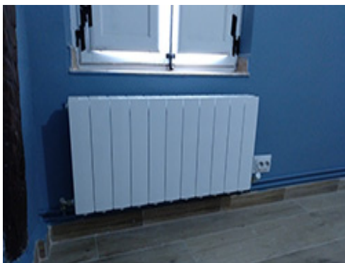
Instalación de caldera de condensación y radiadores con control inteligente
