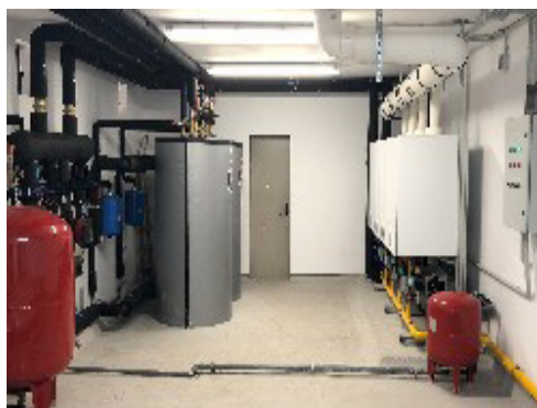
Sala de máquinas comunitaria para producción de ACS y Calefacción
