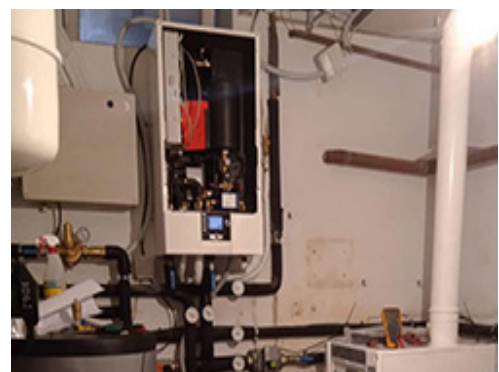
Instalación de aerotermia híbrida con caldera de gasoil en una vivienda
