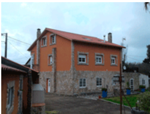
Aislamiento térmico por inyección en cámara de aire en vivienda unifamiliar
