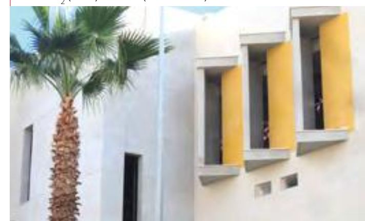
Polideportivo León XII (Málaga) Sistema instalado: Bomba de calor Q-TON con CO 2 (MHI) + KXZ (VRF - MHI)
