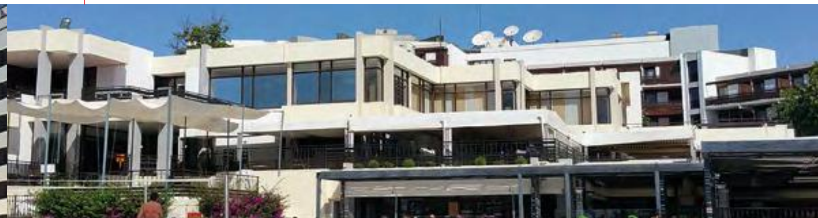
Club Med Balaia (Albufeira - Portugal) Sistema instalado: Bomba de calor Q-TON con CO 2 (MHI)
