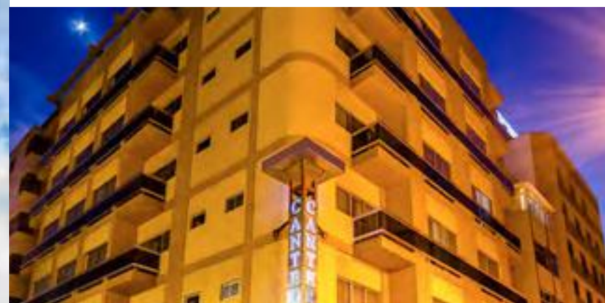
Hotel Alisios Canteras (Las Palmas de Gran Canaria) Sistema instalado: Bomba de calor Q-TON con CO 2 (MHI)
