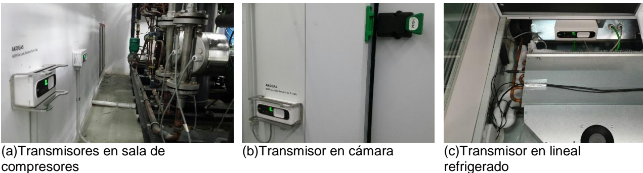
Figura 2: Instalación de transmisores en un equipamiento de refrigeración comercial.
