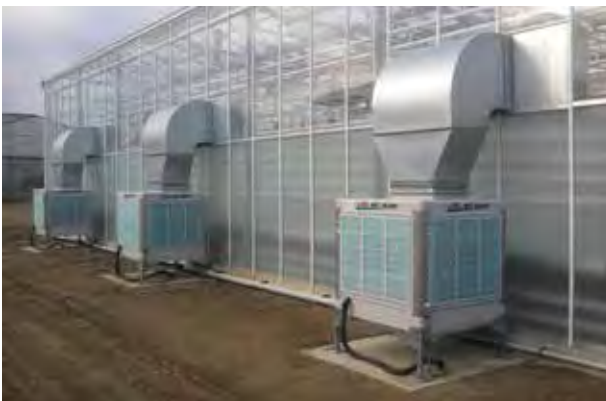
Instalación AD- 15-VS en invernadero
