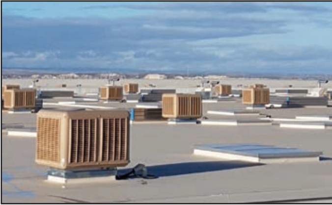
Instalaciones de Pikolin, vista del tejado
