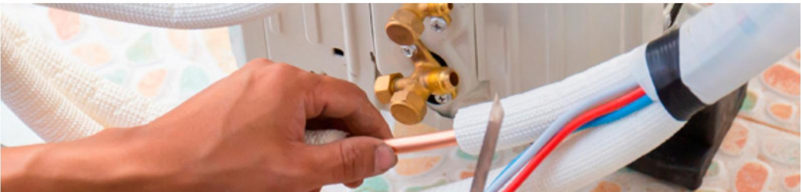
Nos interesa en primer lugar unir la unidad interior a un extremo de las dos tuberías (cuando pongamos la maquina en marcha, por la tubería fina circulara refrigerante líquido, por la tubería gruesa, circulara refrigerante en forma gaseosa) y al otro extremo uniremos la unidad exterior.
