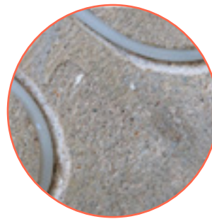
Salas y pasillos de hospitales
