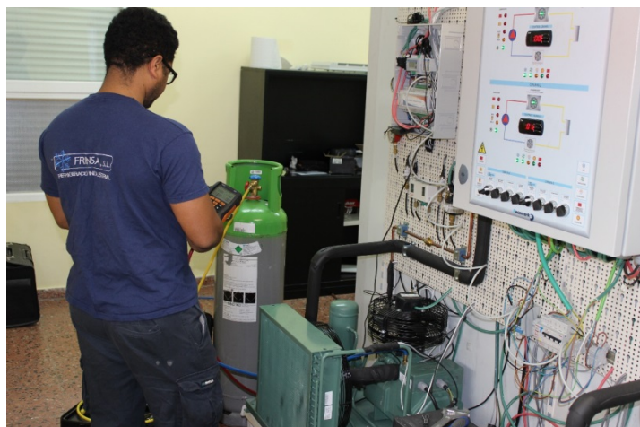
5. Ilustración. COMPROBACIÓN Y AJUSTE DE LA INSTALACIÓN
