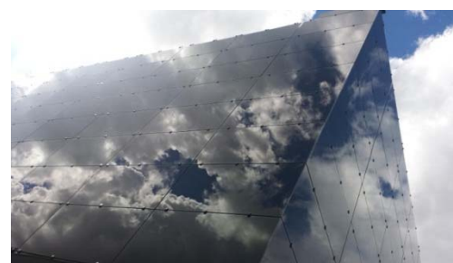
Figura 5: Lucernario fotovoltaico de Onyx Solar
