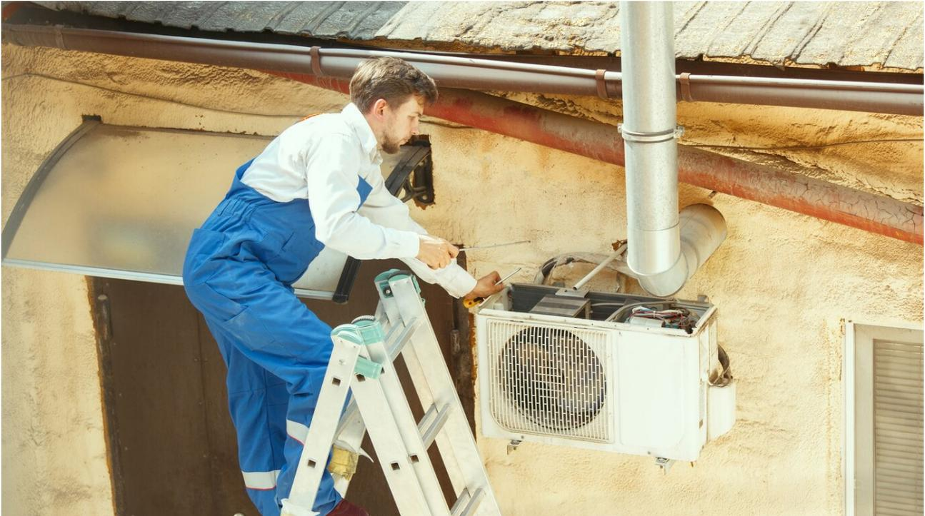
Evaluar las necesidades del inmueble es un paso previo imprescindible a la instalación de una bomba de calor. Hay que tener en cuenta las dimensiones del espacio a climatizar, el tipo de aislamiento de la edificación y su orientación. De esta forma se podrá calcular las necesidades caloríficas reales, para elegir así una bomba de calor con la potencia adecuada.
