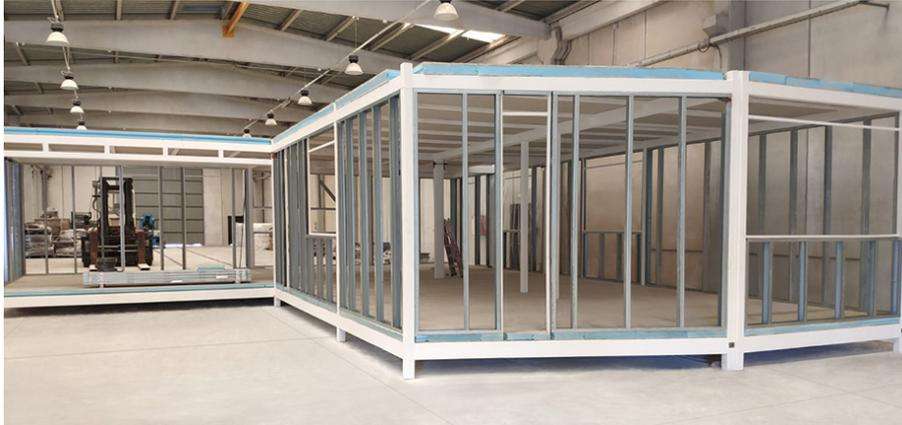
La construcción industrializada se presenta como alternativa a la construcción tradicional. Utiliza procesos y técnicas innovadores y sobre todo se caracteriza por la producción en taller de componentes que se transportan a su ubicación final para su ensamblaje. Se trata de un concepto diferente al de la construcción tradicional en el que prácticamente se produce todo en el sitio. Es lo que se conoce como construcción offsite.
