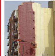
**¿Qué es?** Se trata de una capa de espuma de polietileno proyectada, de 30 mm de espesor mínimo, protegida con pintura o elastómero de poliuretano.
